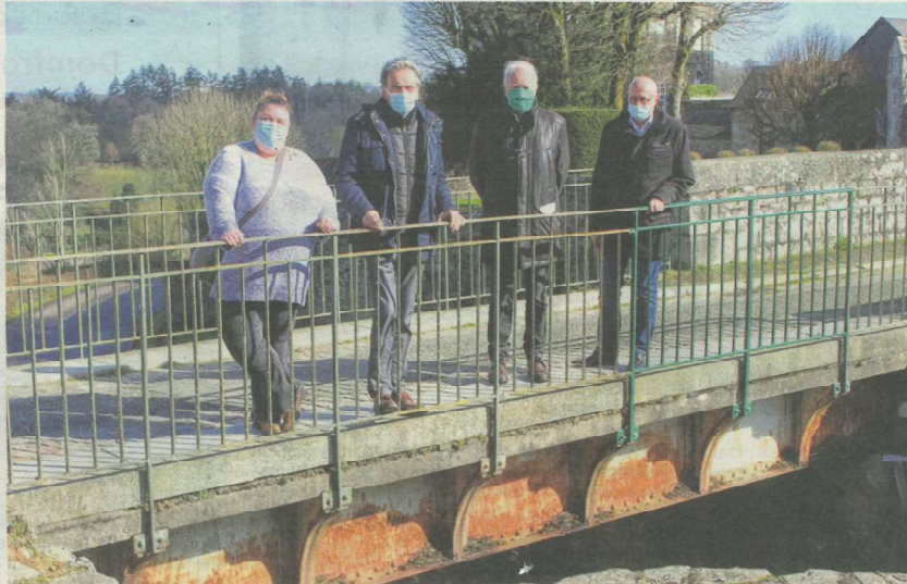
Nathalie Sauré, Bernard Soul, Marcel Folliot et Joël Dromer sur le pont métallique qui sera déconstruit et reconstruit.
